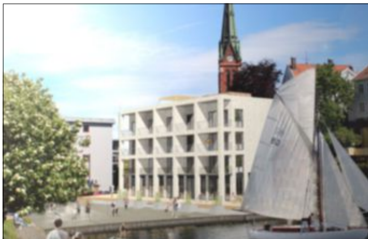
OMFATTENDE: Det skal gjennomføres en omfattende jobb på det gamle Karl S. Hanssen-bygget. FOTO: HRTB ARKITEKTER AS
