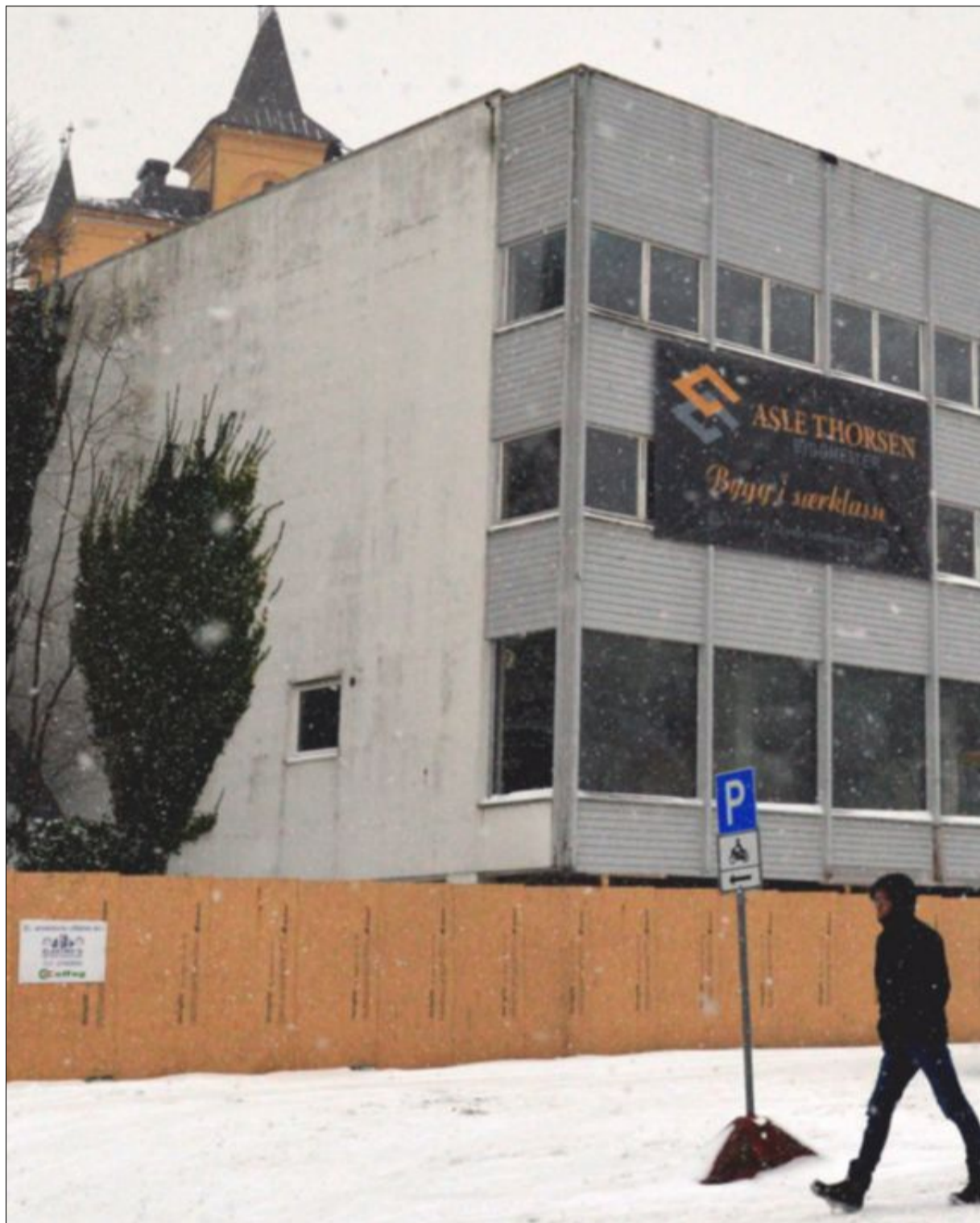
BRUKER 40 MILLIONER: Steinar Moe Eiendom ga 17,8 millioner kroner for det gamle Karl S Hanssen-bygget i Arendal. Leiligheter, kontorer og en kafé, alt i regi av Tyrilistiftelsen. De har inngått en 20 års leiekontrakt på bygget, med mulighet for forlengelse.
